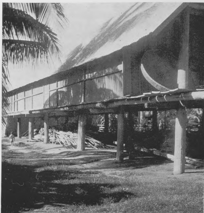
FIG. 23. — Maison « moderne » en tôle et planches. Bbon-ama-Jjông.
